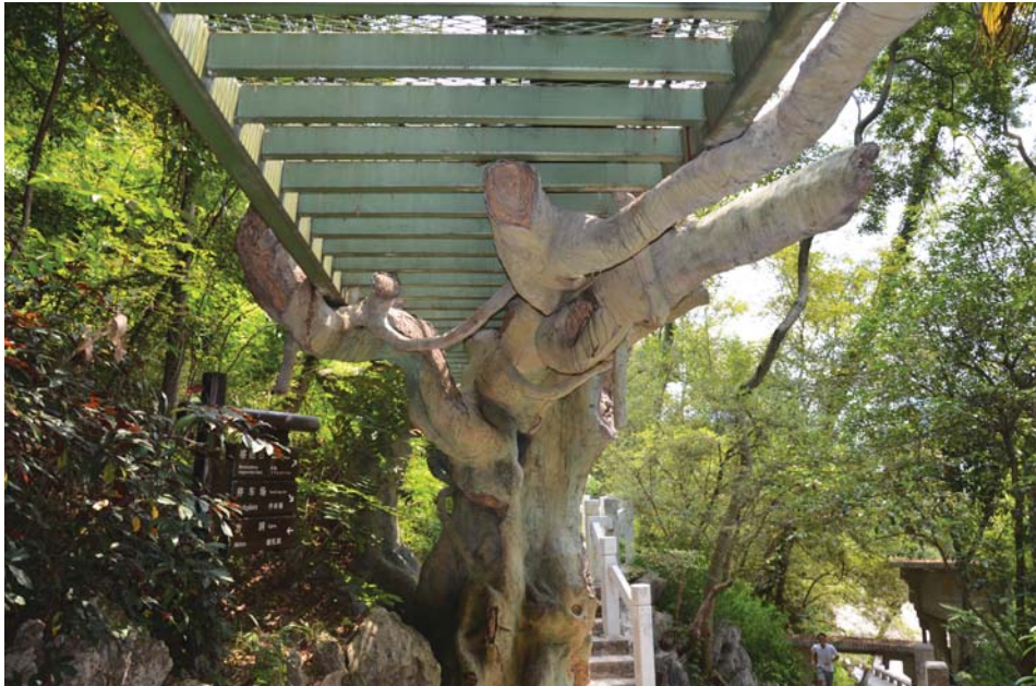
Il. 10a. Guilin, park publiczny na peryferiach; postmodernistyczna, napowietrzna promenada stalowa, której filary stanowią uschnięte zabytkowe drzewa. Fot. W. Kosiński.
