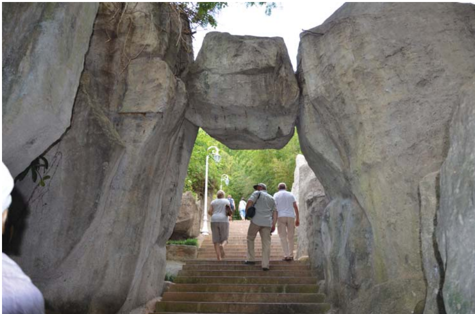
Il. 10b. Guilin, park publiczny na peryferiach; postmodernistyczne sztuczne skały betonowe na promenadzie. Fot. W. Kosiński.
